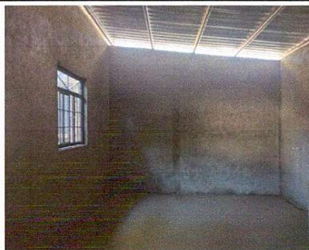
Foto 4: Reparación de repello y cernido de paredes.
