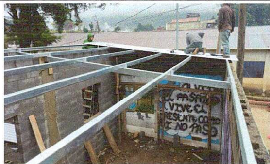
Foto 2: Así quedó las costaneras chapa 26.
