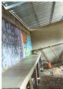
Foto1: Reparación de repello y cernido de paredes.
