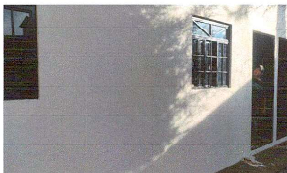
Foto 4: Así quedó la sustitución de paredes según cambios acordados por padres de familia y opf.
