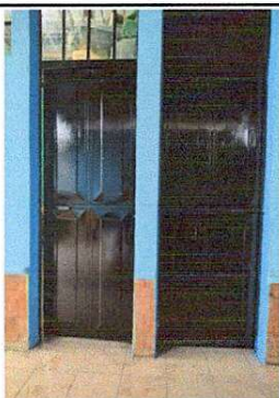
Foto 3: Así quedaron las 15 puertas que se repararon y se pintaron.
