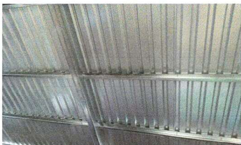
Foto1: Así quedó el techado.
