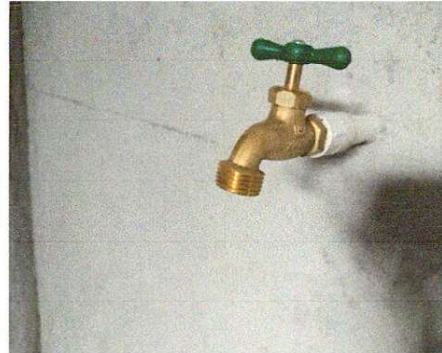
Foto 2: Reparación de red de agua por deterioro.
